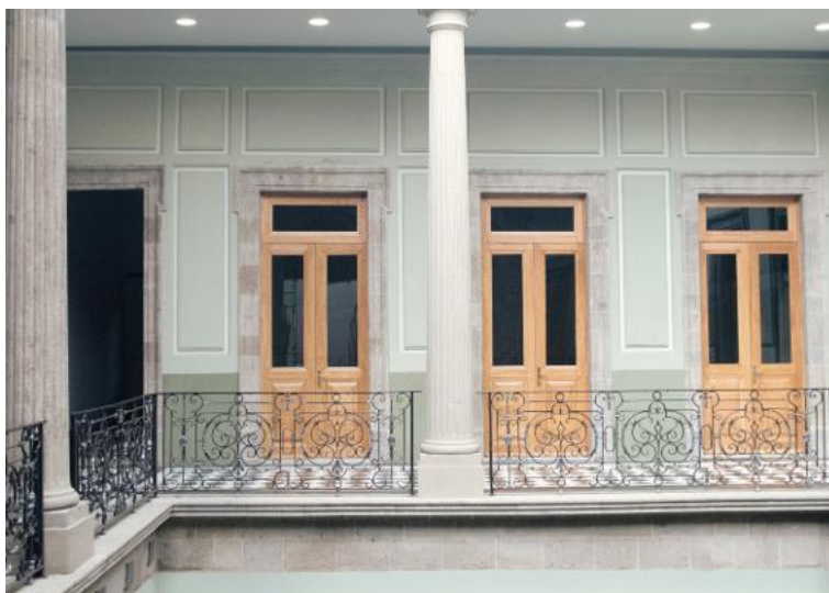
Planta alta de la Secundaria, se le conoce así debido a la ocupación del inmueble por empleados de la SEP en el siglo XX
