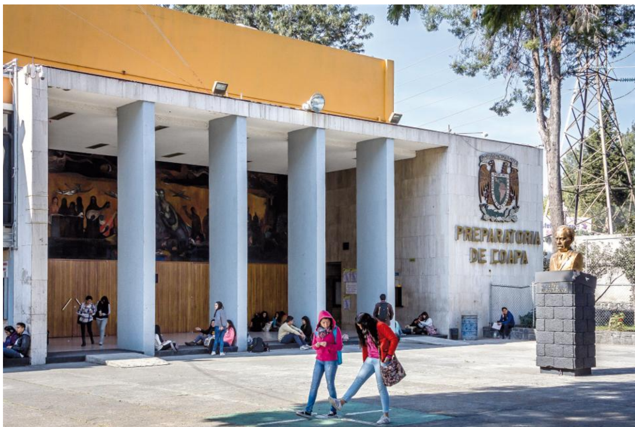
Fachada frontal del auditorio Gabino Barreda.
