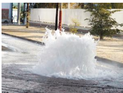
En 2012 se registró que, en la ciudad, 35% de agua potable se desperdició en fugas. Fuente: http://ultrafine.com.mx/una-fuga-deja-escapar-30-000-litros-de-agua-potable/
