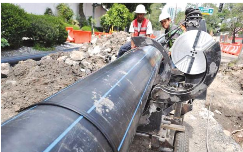
Obras de reemplazo de líneas de drenaje. Fuente: http://elsemanario.com/58400/fuga-de-agua-en-av-zaragoza-provoca-caos-vial/
