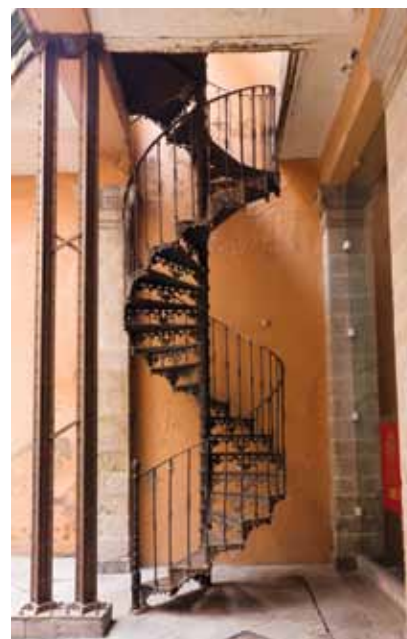
Bella escalera de hierro fundido en la parte posterior de la casa.
