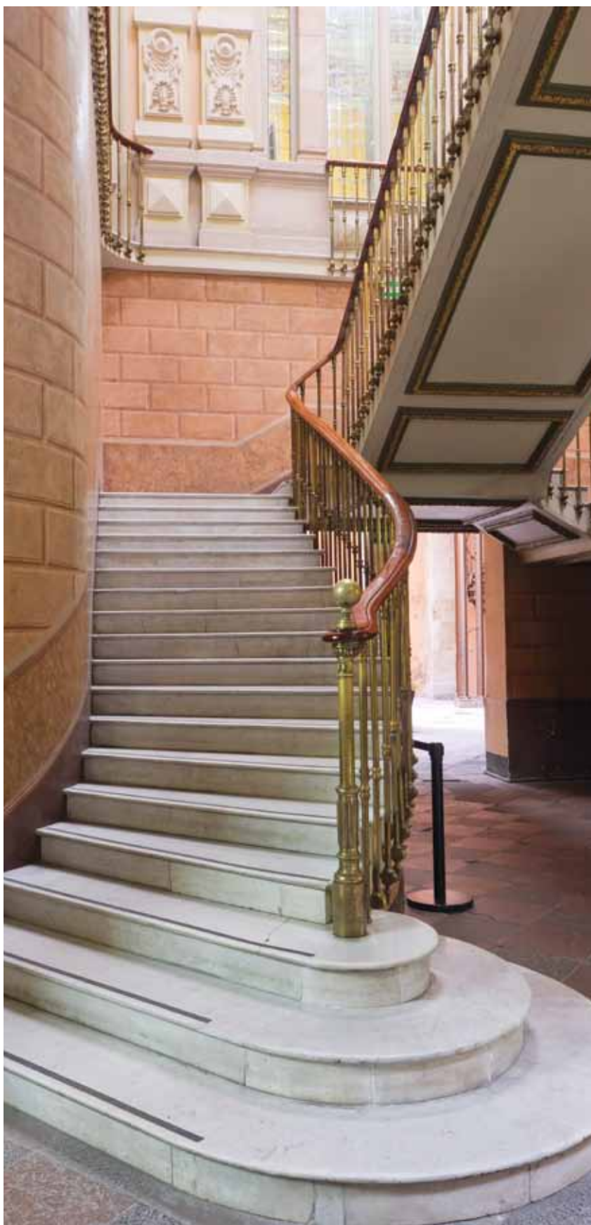
Detalle de escalera de tres rampas tipo imperial, ubicada en el lado norte del patio.
