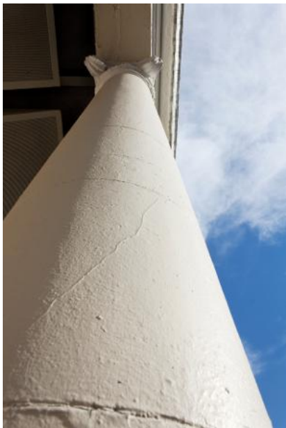
Detalle de columna en primer piso al interior.
