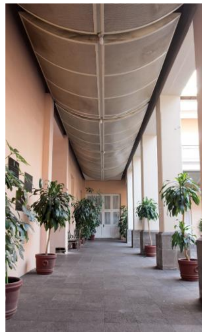
Pasillo en planta baja que rodea el patio principal.
