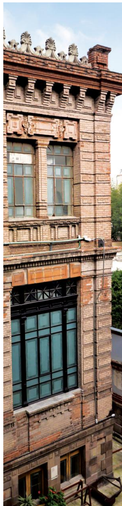
La fachada posterior cuenta con un estilo arquitectónico diferente de la fachada principal. Foto: Felipe Carrasco.
