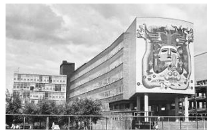
La construcción de un andador cubierto afectó la plataforma visual de la obra plástica.
