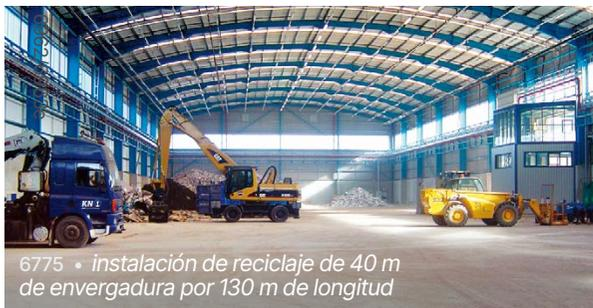
6775 • instalación de reciclaje de 40 m de envergadura por 130 m de longitud
