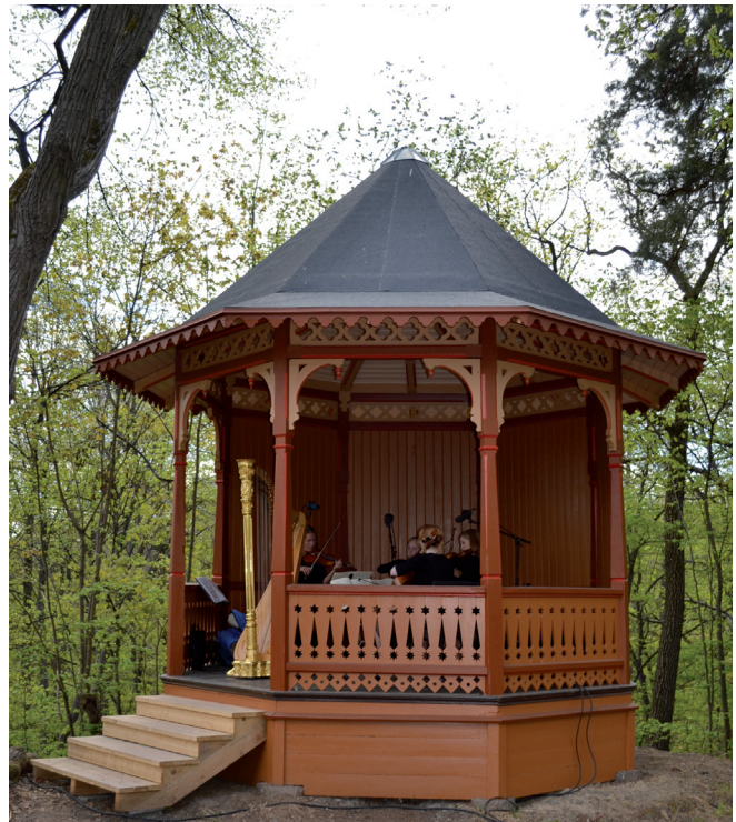
Den nyrestaurerte musikkpavillionen, som ble bygget samtidig med glassverandaen ca. 1885. (Foto: Anne Husbyn.)
