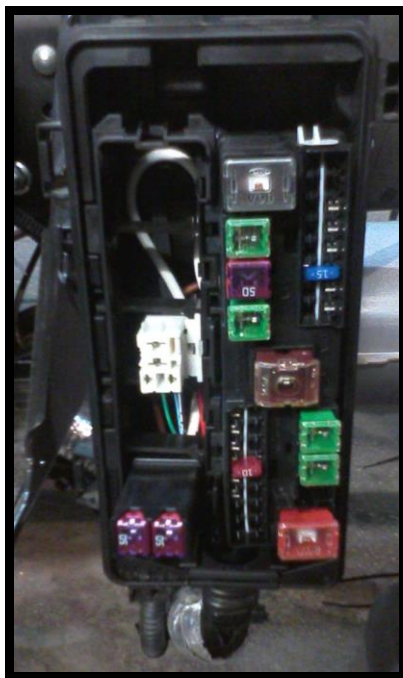
Figura 23: cassetta fusibile alimentazione piattaforma
