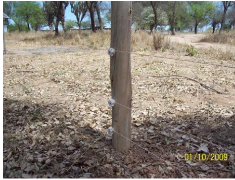
Imagen 27: Poste para instalación de alambrado eléctrico.
