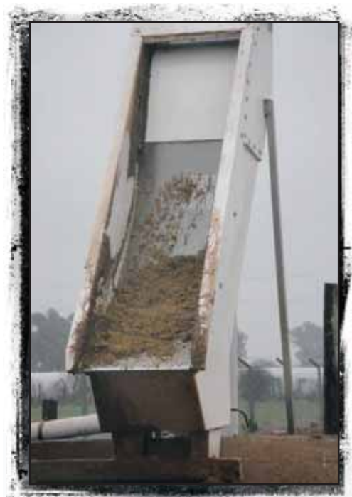
f Foto 12.10. Tamiz ubicado previo al ingreso de la laguna de estabilización en la EEA Rafaela (INTA).
