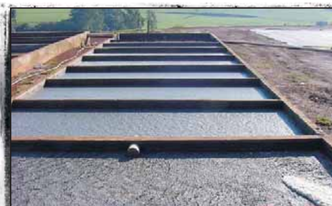
f Foto 12.9. Lagunas impermeabilizadas.
