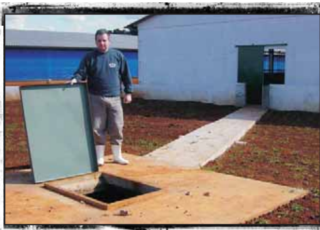
f Foto 12.6. Drenajes por gravedad interconectados con fosas de distintos galpones.
