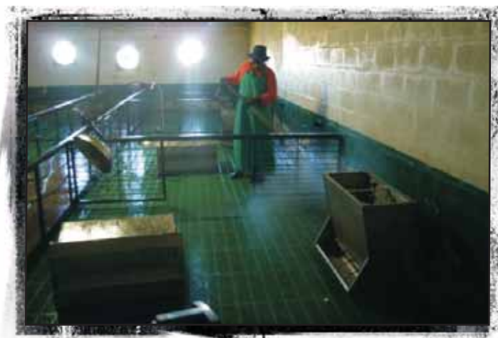
f Foto 12.7. Limpieza con chorro de agua a presión. Gentileza Est. Vedia Chaco (INTA).
