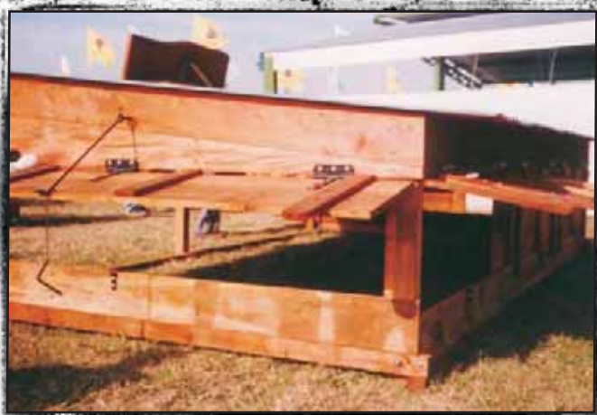
f Foto 5.20. Reparos.
