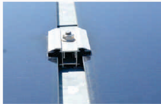
Figura: Grampos laminados com borrachas EPDM.
