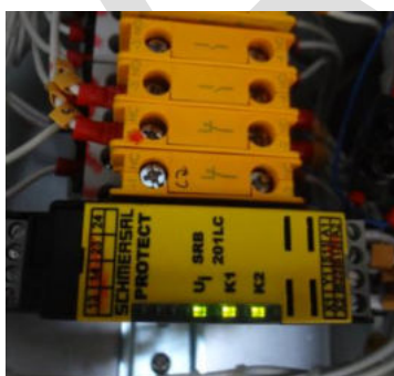
Funcionamento do relé dos dispositivos de segurança
