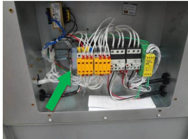
**Contator com contatos positivamente guiado**
