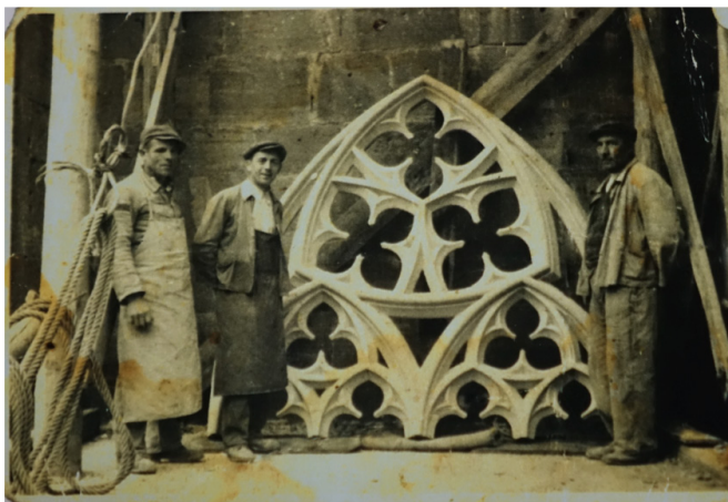
Restaurierung der Maßwerkfenster, von links: Bulheller (Althausen), Anton Seith (Reichenbach), Engelbert Volk (Fridritt)
