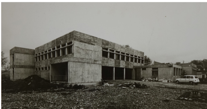
Jugendzentrum mit Kindergarten im Rohbau, 1972
