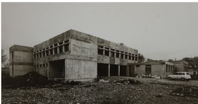
Jugendzentrum mit Kindergarten im Rohbau, 1972
