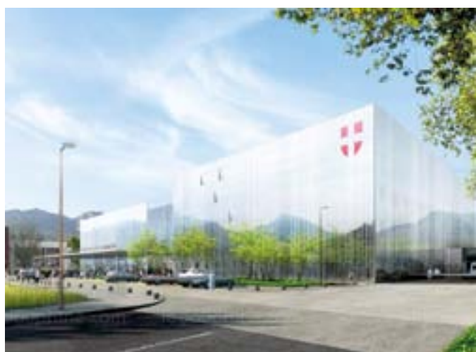
Ospedale di Chambéry - Chambéry (Francia)
