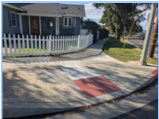
ADA Compliant Sidewalks
