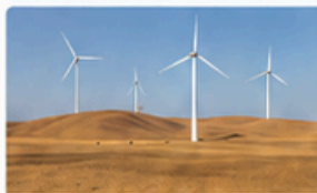
PARC ÉOLIEN DE BOUJDOUR
