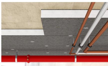
Befestigung von Dämmplatten
