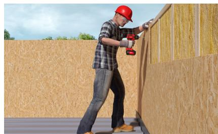
Befestigung von OSB-Platten auf Holzständern im Holzrahmenbau
