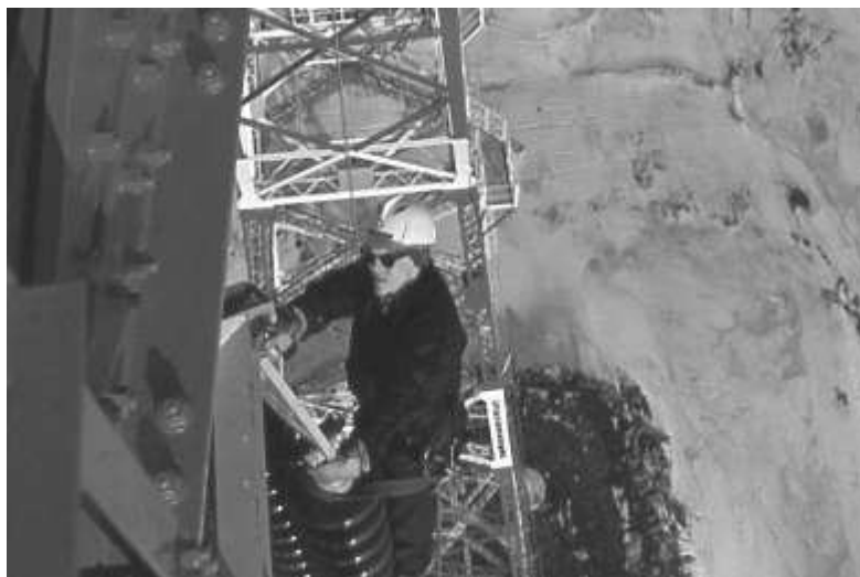
Inspection finale par Michel Bornais d'un ensemble d'isolateurs de suspension dans un pylône de la traversée 735KV du fleuve Saint-Laurent à Saint-Laurent, Île d'Orléans, printemps 1966. (Collection Michel Bornais)
