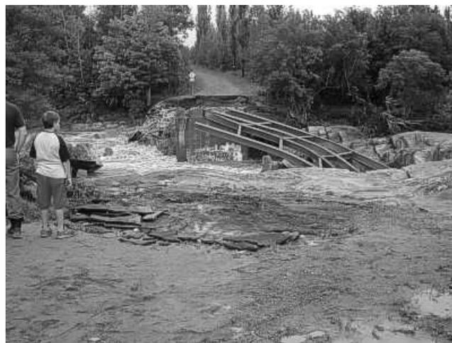
Pont à structure métallique tordue et arrachée de ses butées, Chemin du Moulin, Warwick. (Photographie : Ressources naturelles Canada) (Source : [http://sts.gsc.nrcan.gc.ca/clf/boisfrancs\\_flooding\\_photos\\_fr.asp](http://sts.gsc.nrcan.gc.ca/clf/boisfrancs_flooding_photos_fr.asp))
