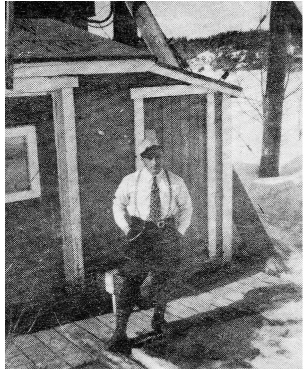
Jean-Baptiste Kirouac travailla pendant de nombreuses années au réservoir d'eau potable du lac Comeau. Rappelons qu'en 1943, le réservoir fournissait en eau la ville et l'usine.
