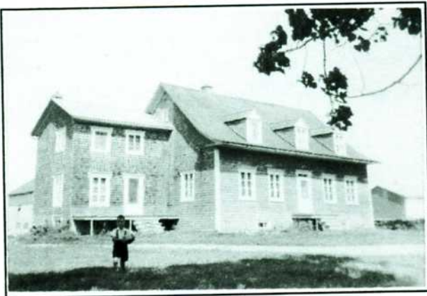
La maison après le déménagement de 1938
