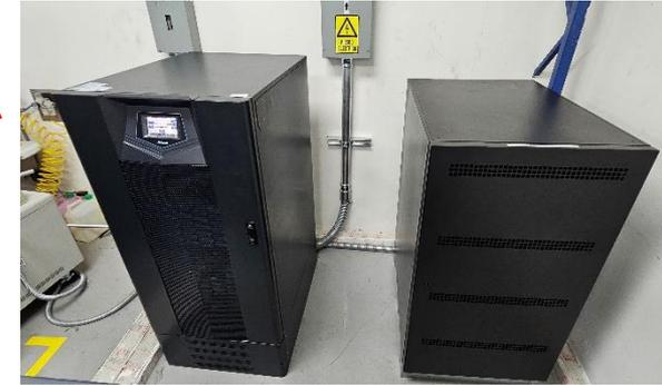
**AB-TAUR60K, 60KVA Trifásico 400V.** Para: **1)** Calidad de energía, **2)** respaldo de energía y **3)** protección eléctrica a una **máquina industrial etiquetadora de camisas** en el departamento de San Salvador.
