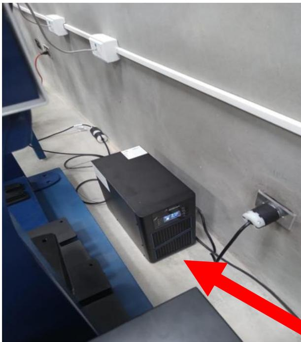
**AB-MSIII6000, 6KVA Y ARPLUS-ECO3000, 3KVA** monofásico 208V/120V para: **1)** calidad de energía, **2)** respaldo de energía y **3)** protección eléctrica para **equipos de laboratorio de estudio de suelo** en el departamento de La Libertad, El Salvador.
