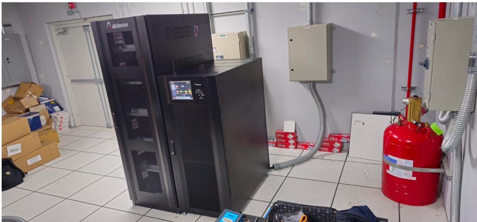
**AB-TAURM120K20X-30U, 120KVA Trifásico 208V. Para: 1) Calidad de energía, 2) respaldo de energía y 3) protección eléctrica a equipos de misión crítica (centro de datos) en el aeropuerto internacional de EL Salvador.**
