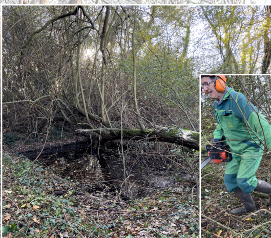
En novembre réhabilitation du lavoir du Carouge (Petite équipe mais efficace)
