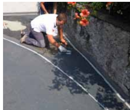
Applicazione del rivestimento per superfici Triflex DeckFloor nella versione I.
