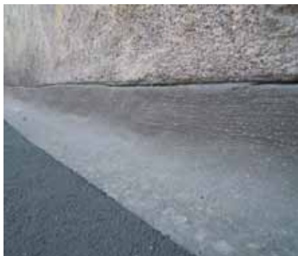
... e collegamenti alla parete con Triflex ProDetail.
