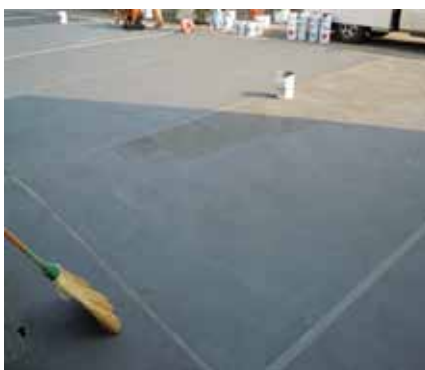
Superficie del parcheggio dopo la rimozione della sabbia quarzosa in eccesso.
