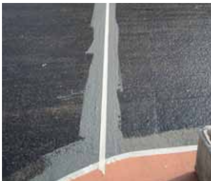
Primerizzazione della superficie con Triflex Cryl Primer 222. Impermeabilizzazione dei giunti...
