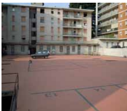
Primerizzazione con Triflex Cryl Finish 209 in terracotta e marcatura con Triflex Cryl Finish 209 in color grigio traffico.
