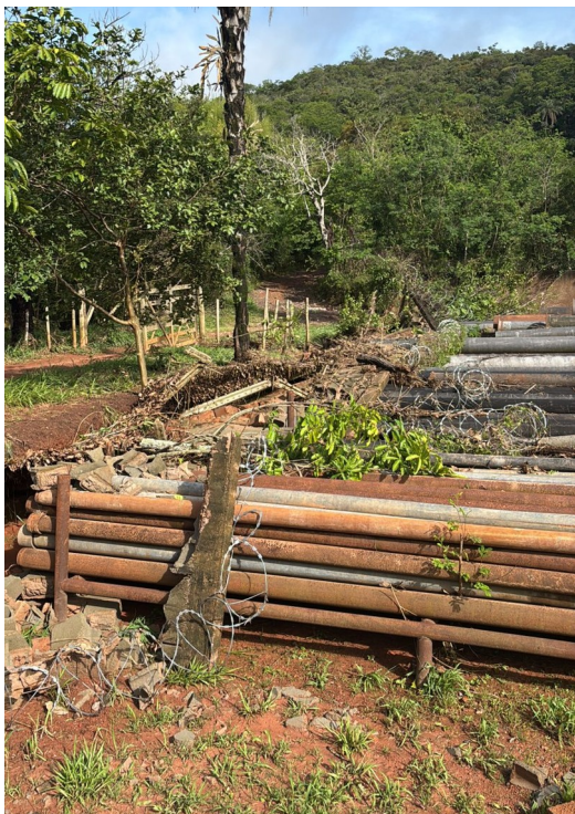
Fotografia 1 - MURO ETA GATOS COLAPSADO LATITUDE -19.585054°, LONGITUDE -43.195531°.
