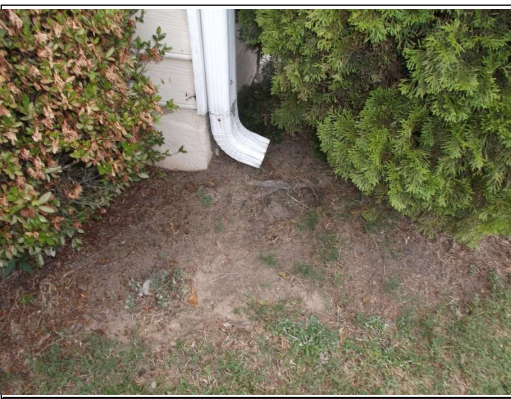
Downspouts pour at foundation
