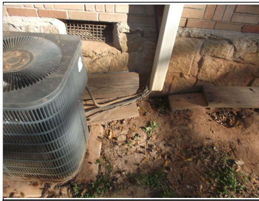
Condensate pipe pour at foundation
