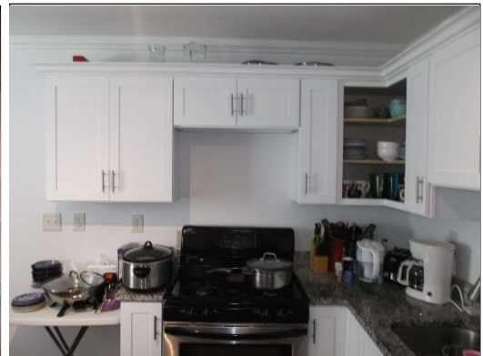
Missing exhaust fan
