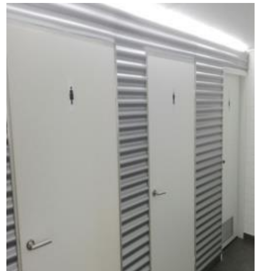
Toegang tot toilet en kleedruimte
