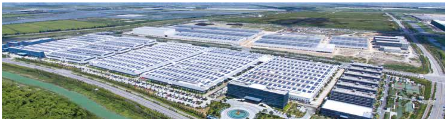
BASE DI PRODUZIONE DI POMPE PER APPLICAZIONI DOMESTICHE E COMMERCIALI
