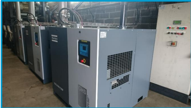
Reemplazo de aspiradora central
