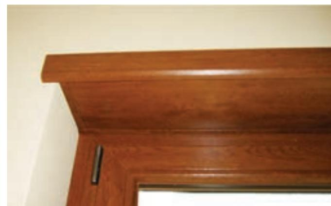
Il profilo 3365, in combinazione con i pannelli da 9mm in pvc espanso e con i tappi art. 3260, può essere utilizzato come cielino (nel caso ad esempio di cassonetti incassati, intonacati internamente ed esternamente, con ispezione dal basso).
