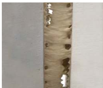
Difetti di tenuta dovuti a ritiro della schiuma nel tempo.
