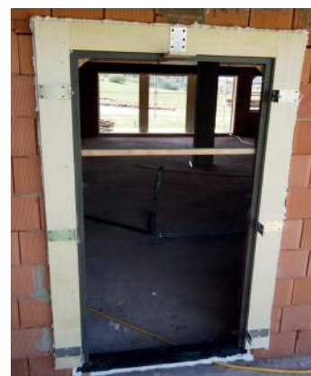
Controtelaio specifico per il fissaggio delle staffe porta-cardini e dell'incontro fermascuri. La traversa inferiore prima esistente è stata eliminata.
