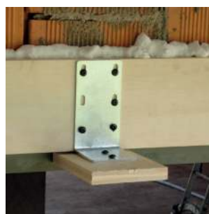
Fig. 1 Particolare della staffa con tavoletta di legno fissata nella mezzeria del traverso superiore.
