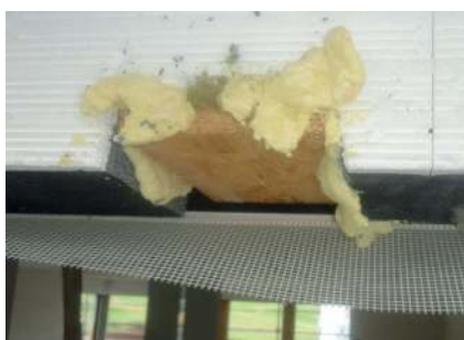
Fig. 2 Ritaglio del pannello del cappotto e riempimento con schiuma dello spazio vuoto tutt'intorno.
