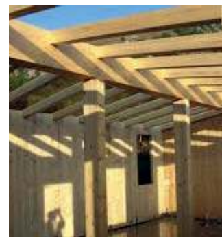
Costruzione con intelaiatura in legno.
