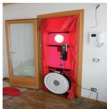
L'A Wert test è in grado di verificare in modo scientifico le perdite di carico lungo il perimetro della finestra e quindi l'efficienza del sistema di posa.
