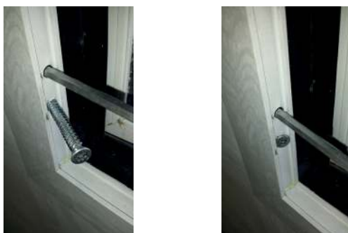
Nell'individuazione della posizione dei fori di fissaggio bisogna fare attenzione a mantenere una distanza di circa 30mm tra la posizione del regolo e la turbovite.
