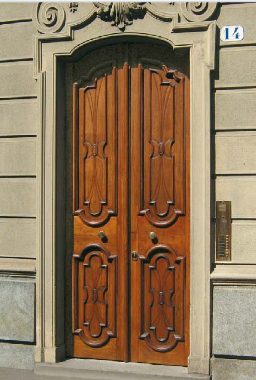
Realizzazione porta a due ante con recupero di pannello esistente.
