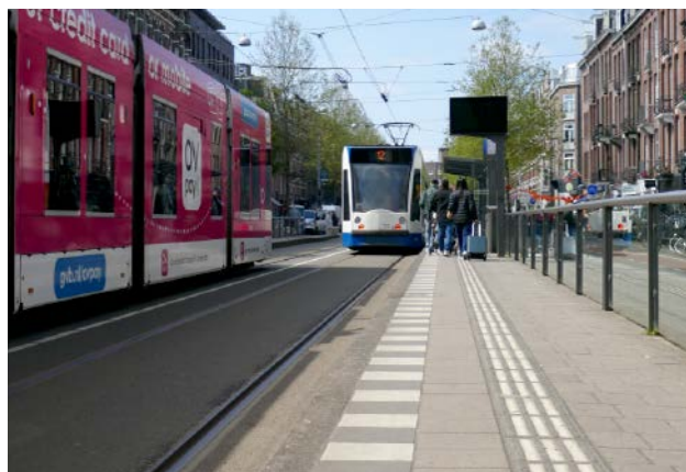
Figuur 6.3 Voorbeeld van blokmarkering tramhalte De Pijp, Amsterdam (CROW, 2025a)
