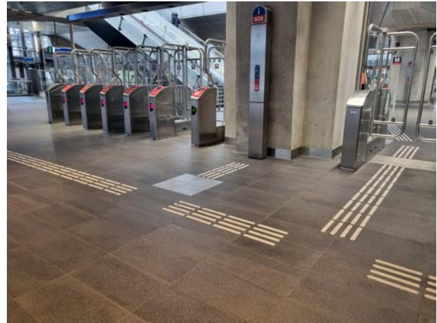
Figuur 6.7 Objectmarkering klanktegel bij service- en alarmzuil (TG-lining)
