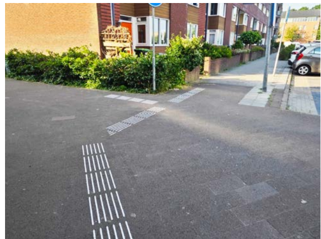
Figuur 4.13 Overgang geleidelijn in natuurlijke gidslijn (TG-lining)
