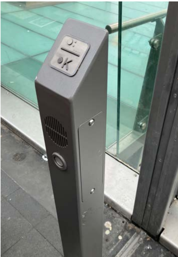
Figuur 8.5 Paal met tactiele informatie en audioknop op busstation Amsterdam Centraal
