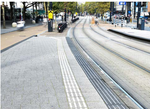
Figuur 6.5 Routegeleiding in omgeving van tramhalte (TG-Lining)
