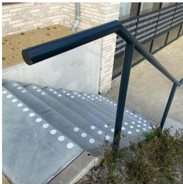
Figuur 4.9 Trapmarkering met leuning (TG-lining)
