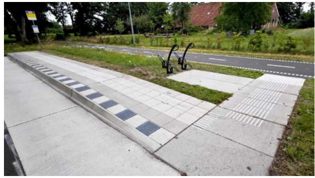
Figuur 6.6 Voorbeeld van onveilige oversteeksituatie voor mensen met visuele beperking (TG-Lining)
