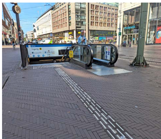
Figuur 4.10 Geleideroute en waarschuwingmarkering naar entree openbaar vervoer (TG-Lining)
