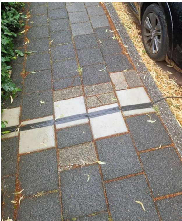
Figuur 7.6 Kabelgoot
