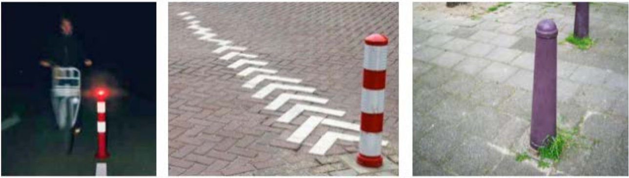
Figuur 3.2 Voorbeelden van contrast bij paaltjes en een voorbeeld (rechts) met weinig contrast (CROW, 2022a)
