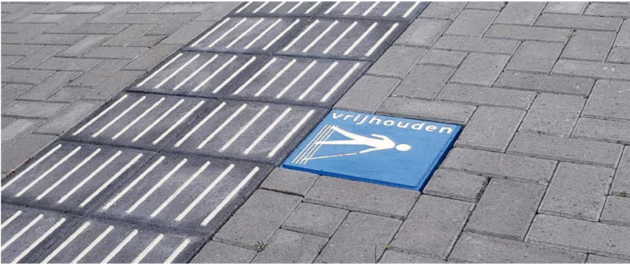
Figuur 4.22 'Houd de lijn vrij'-tegel (TG-lining)
