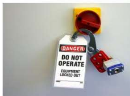
Figura 5 – Aplicação do cadeado de bloqueio
