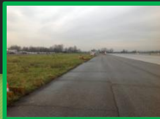
Stato di fatto pavimentazioni
