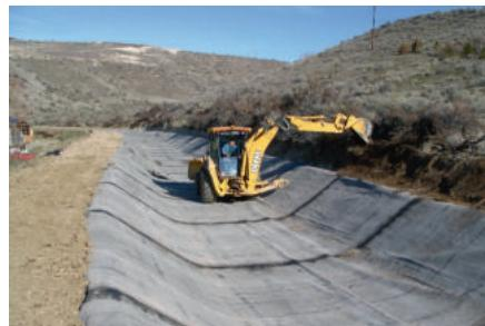
La plegabilidad importante de COLETANCHE® permite un anclaje transversal a todo lo largo de los canales, a fin de:
