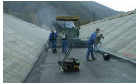
Gracias a su composición a base de betún, COLETANCHE® permite instalar aglomerado asfáltico en caliente sobre la geomembrana.
