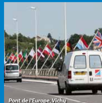
Pont de l'Europe, Vichy
