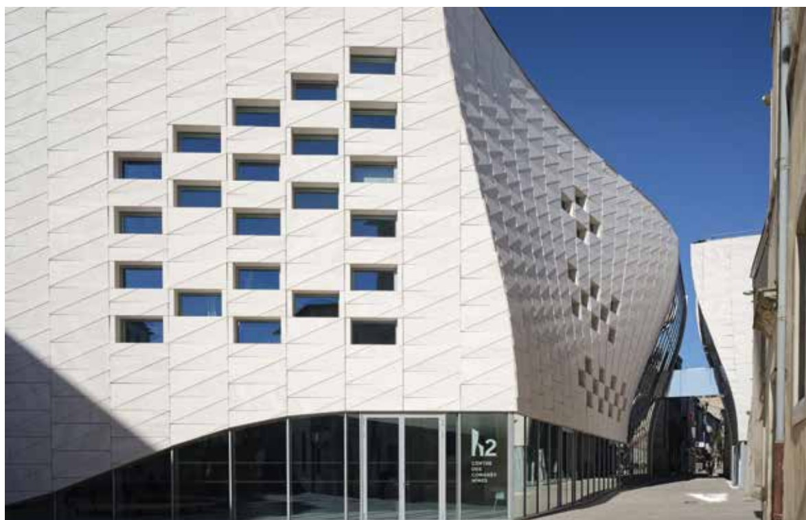
Avec ses 8 500 m 2 , h2 permet à Nîmes de se positionner sur près de 80 % des congrès nationaux. La salle de restauration événementielle est achevée depuis le mois de juin avec 620 m 2 intérieurs et 90 m 2 de terrasse couverte.
