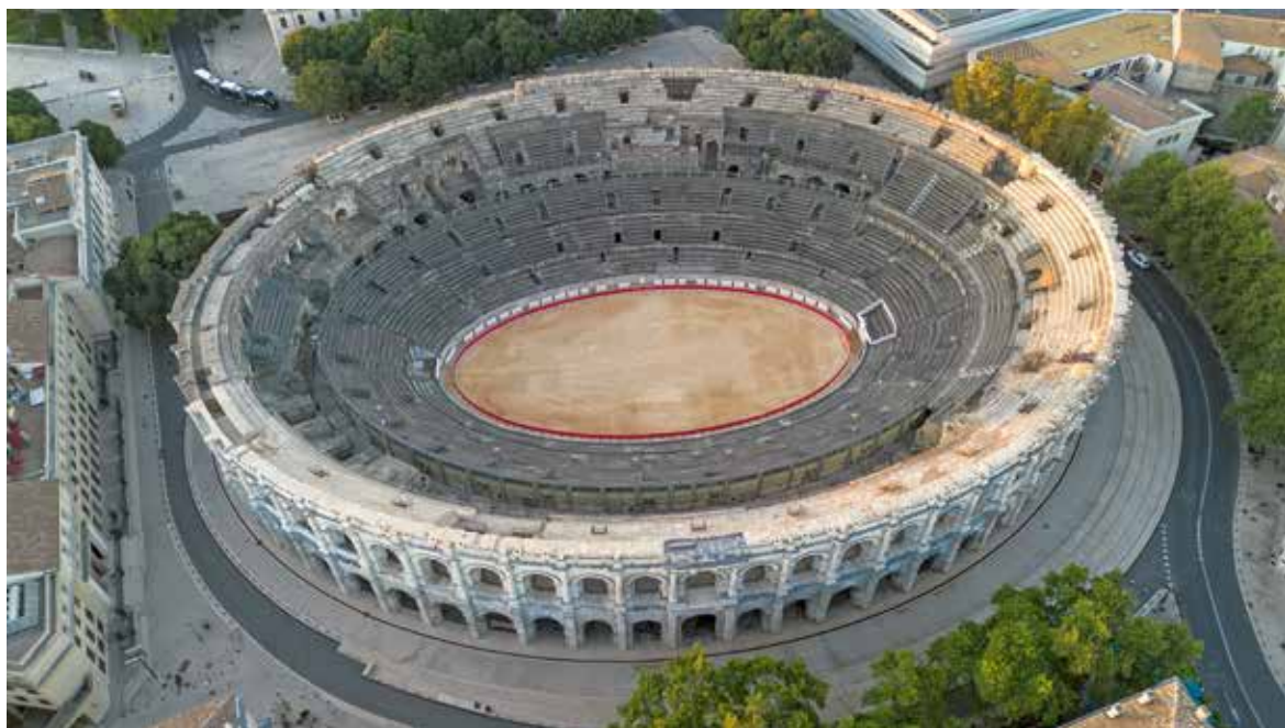
La moitié nord de la couronne extérieure (plus claire sur la photo) a déjà été restaurée et protégée.
