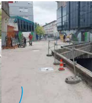
Traitement des nids de poule sur le réseau routier.
