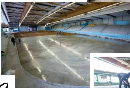
Treillis métallique et première dalle
