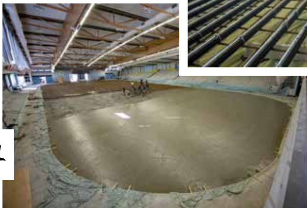
Pose du circuit de froid
