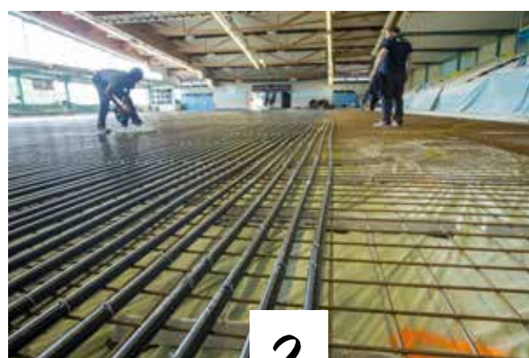
Pose du circuit de froid
