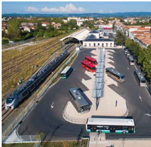
Les pôles d'échanges multimodaux, à Castres et Mazamet, connectent le train, le bus, la voiture et le vélo.
