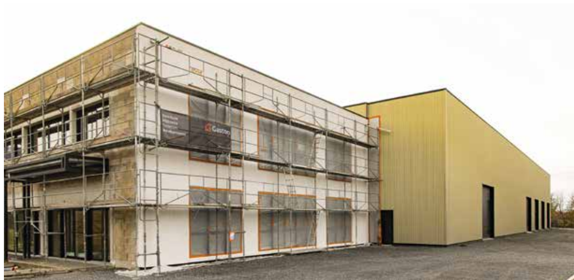
Le nouveau bâtiment bientôt opérationnel.
