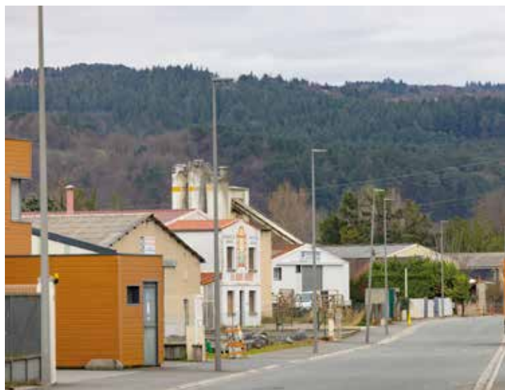
La rue de la Mécanique a été rénovée lors de la précédente phase de travaux.
