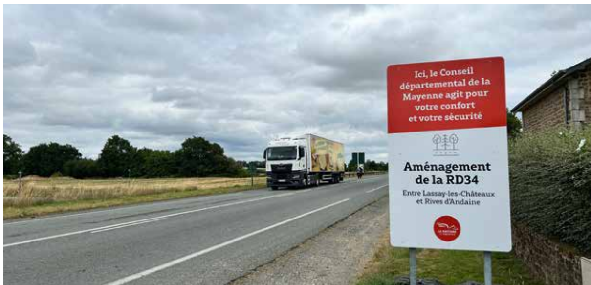
▲ La route départementale 34 entre Lassay-les-Châteaux et Rives d'Andaine (Couterne) va connaître d'importants travaux à la rentrée. Retrouvez toutes les infos routières sur maymobilité.fr
